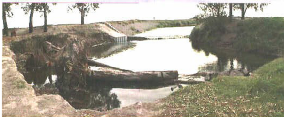
Reacondicionamiento de defensas en Arroyo Sauce Chico, Pcia. de Buenos Aires
