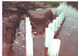
Detalle de espigón en Río Albigasta, Pcia. de Catamarca
