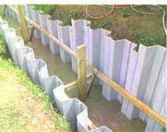
Vista de zanja de drenaje natural
